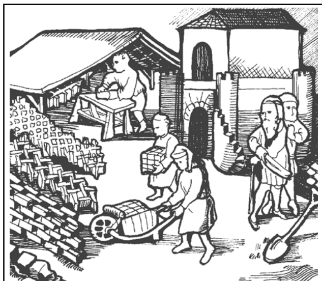
Senmedeltida tegelbruk. Från skjutet i bakgrunden, där tegelslagaren "bakar" stenarna, transporteras teglen till torkning vid sidan om ugnen (i bildens övre högra hörn) där bränningen ska ske. Illustration efter nederländskt träsnitt av okänd konstnär.
